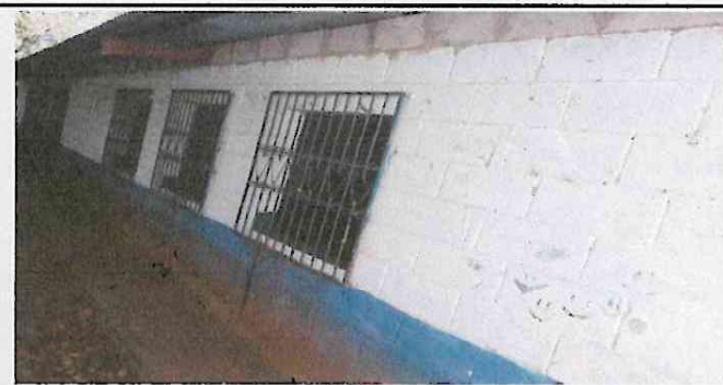
Foto 4: Pintura en muros exteriores e interiores
