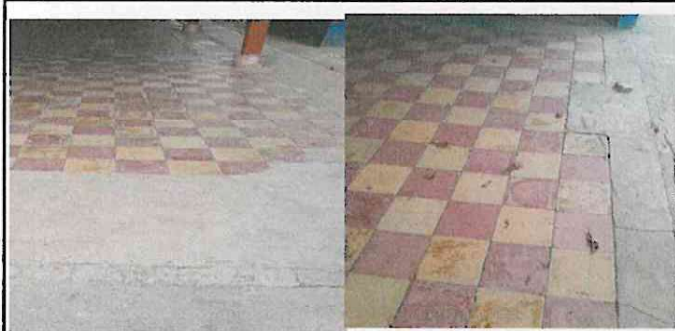
Foto 5: reparación de piso cerámico
