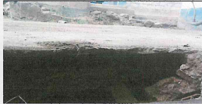
Foto 2: Mantenimiento a reposaderas, de drenajes sanitarios
