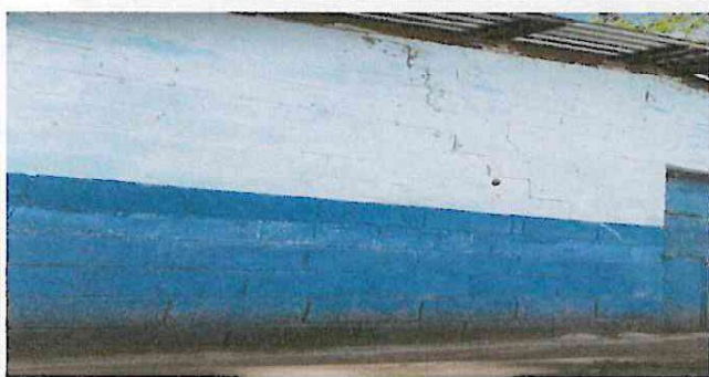
Foto 3: Pintura en muros exteriores e interiores
