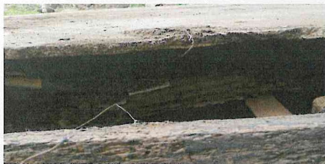
Foto 1: Mantenimiento a reposaderas, de drenajes sanitarios
